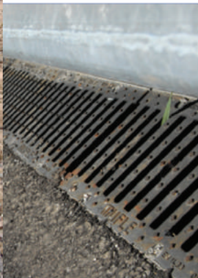
KANAL WING 200/250 + ÇATAL IZGARA C250 DÖKÜM
