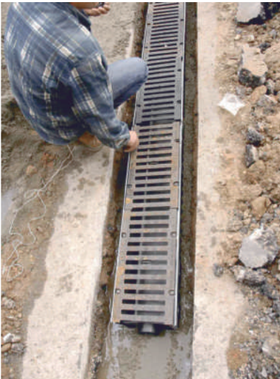
KANAL WING 200/250 + ÇATAL IZGARA C250 DÖKÜM
